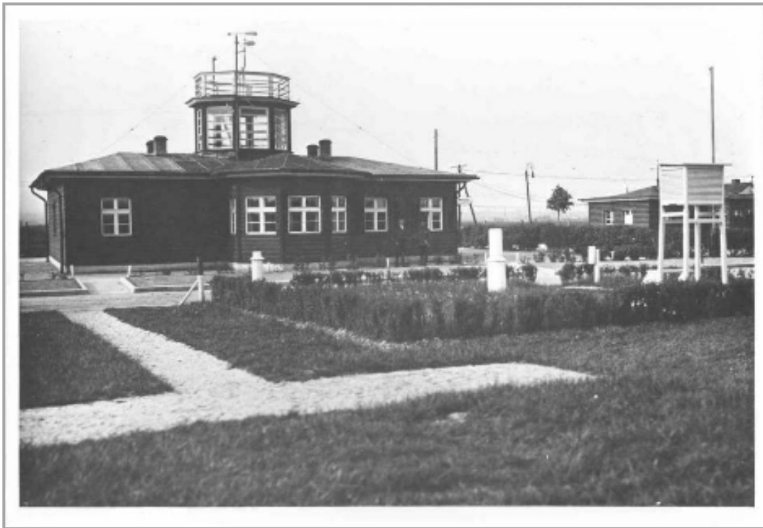
Stacja meteo na lotnisku
